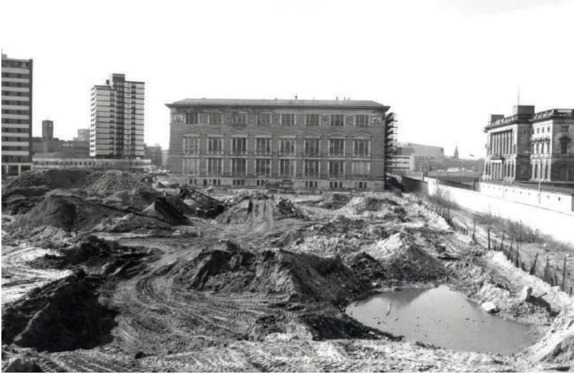
En esta imagen pueden verse el terreno de la Gestapo y el edificio Martín Gropius en 1981. Adelante, basurales en uno de los márgenes de la zona conocida como "el desierto urbano". A la derecha, el Muro, y detrás, en Berlín Oriental, el antiguo edificio parlamentario prusiano (Foto: Landesarchiv Berlin).
